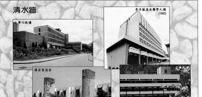
清水牆選用高質的板模及線條設計,於鋼筋混凝土牆結成拆模後,表面不加粉飾,色澤暗淡自然,重結構形式,富蒼樸、莊嚴、規律感而不誇張色彩裝璜。
