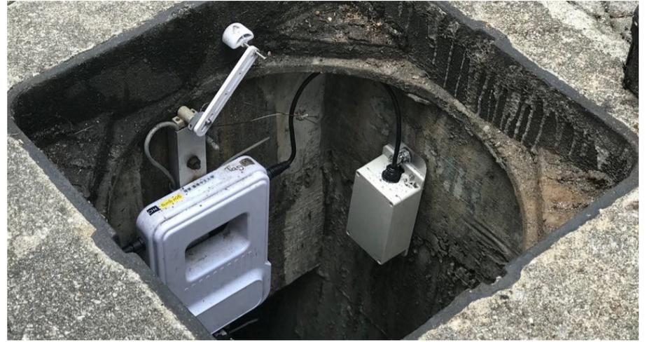
▲ 監測系統備有五個傳感器，分別量度水位、三種有害氣體濃度和顯示沙井蓋的開關狀態
